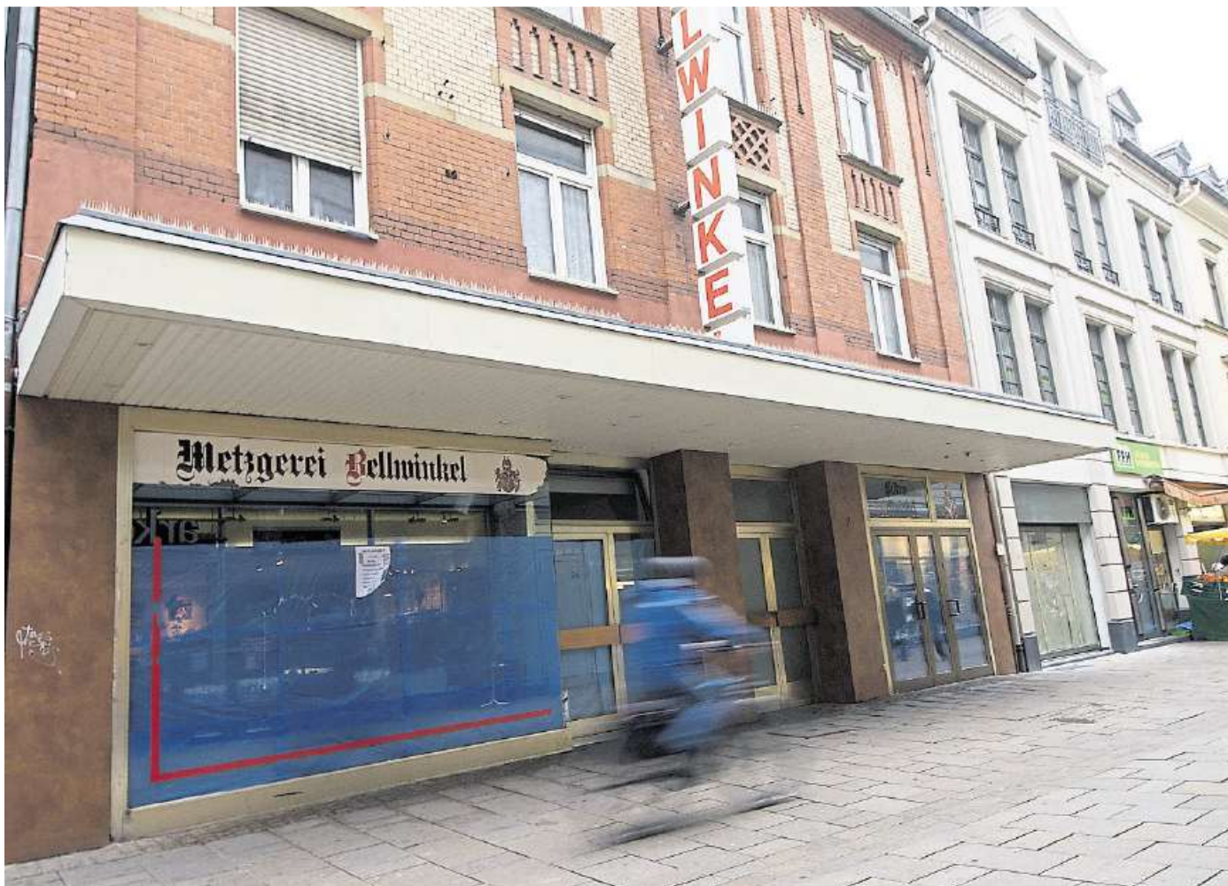
Abbruchantrag ist gestellt: Das Bellwinkel-Haus in der Schulgasse.
