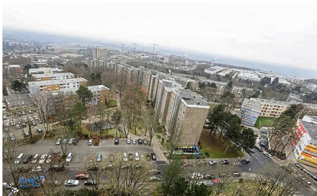
Im Schelmengraben sollen durch Nachverdichtung die meisten der neuen Sozialwohnungen entstehen.
